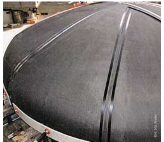
3: Fertigung eines gewölbten Bodens mit Durchmesser 2 800 mm
